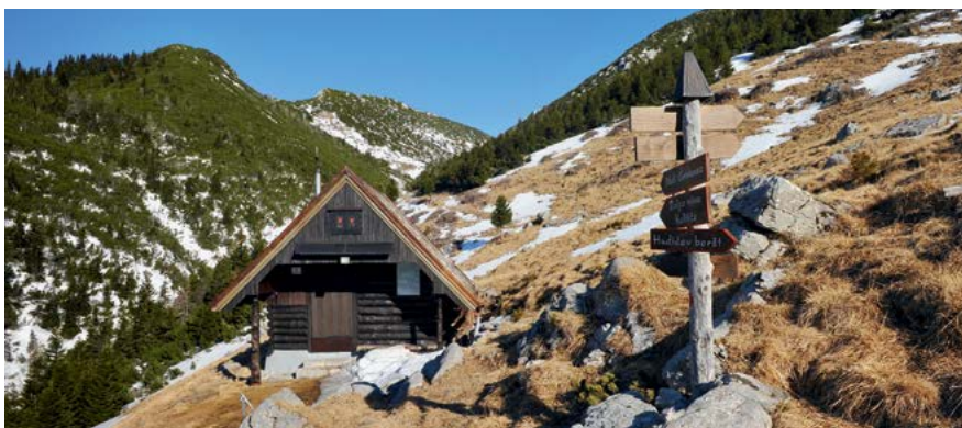
Brunarica pod Srednjim vrhom; nad streho vidimo z ruševjem poraščen Mali Grintovec. Foto Franci Horvat
