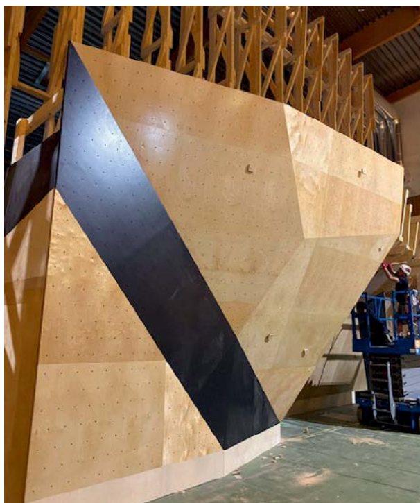
Montaža Foto Citywall
