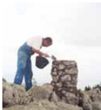
Zidava podstavka orientacijske table
