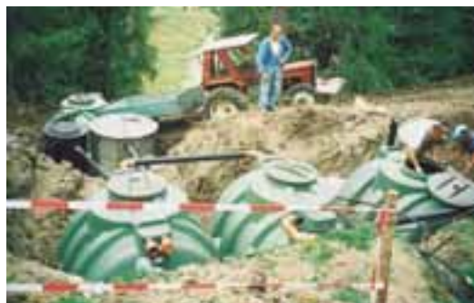
Montaža čistilne naprave (foto: Danilo Sbrizaj)
